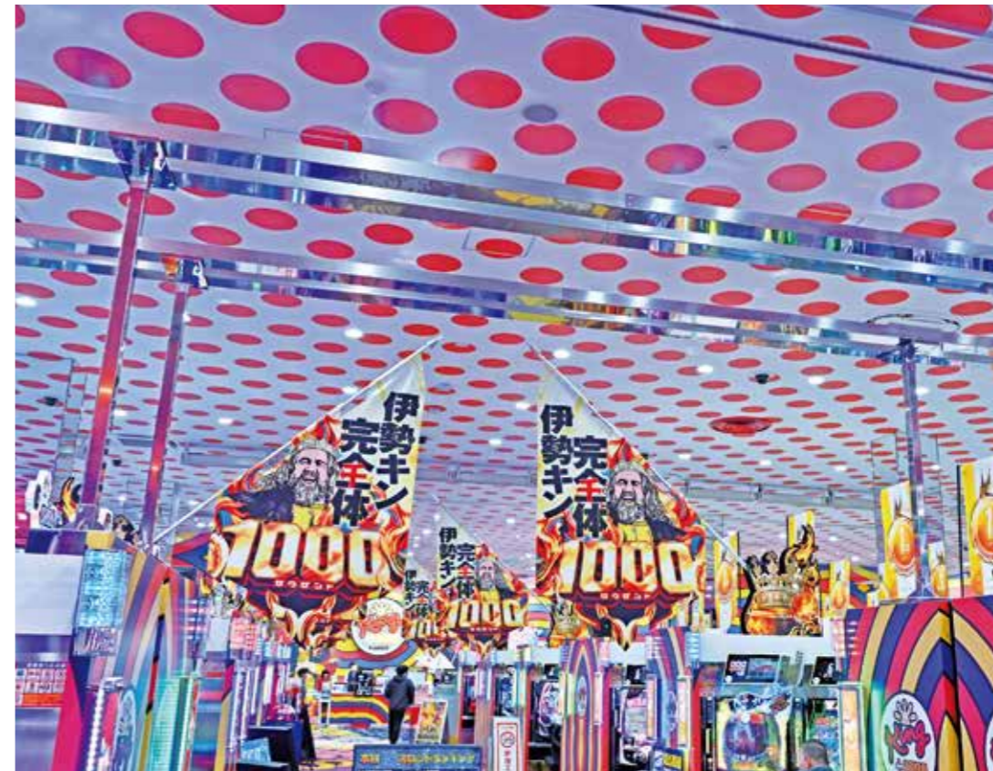
店舗の高いところを通る、紙幣搬送路。鏡面デザインのため見た目にも違和感がない。
