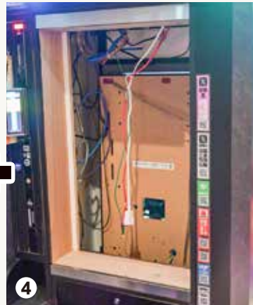
④ 再び木枠及び4本のビスを取り付け。
