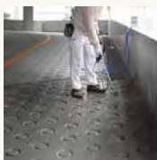
立体駐車場スロープ
