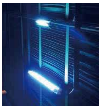
UV-C発生装置を取り付けダクト内でウイルスを殺菌。
